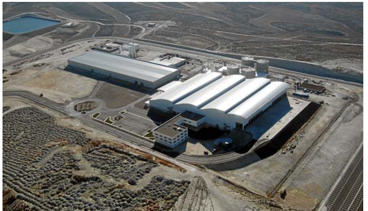
◆ INSTALACIONES Vista del Complejo para Tratamiento de Residuos Urbanos de Zaragoza.
